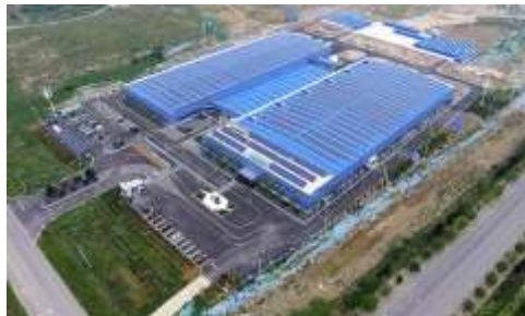
Rongke Power – 200MW/800MWh (w budowie)
