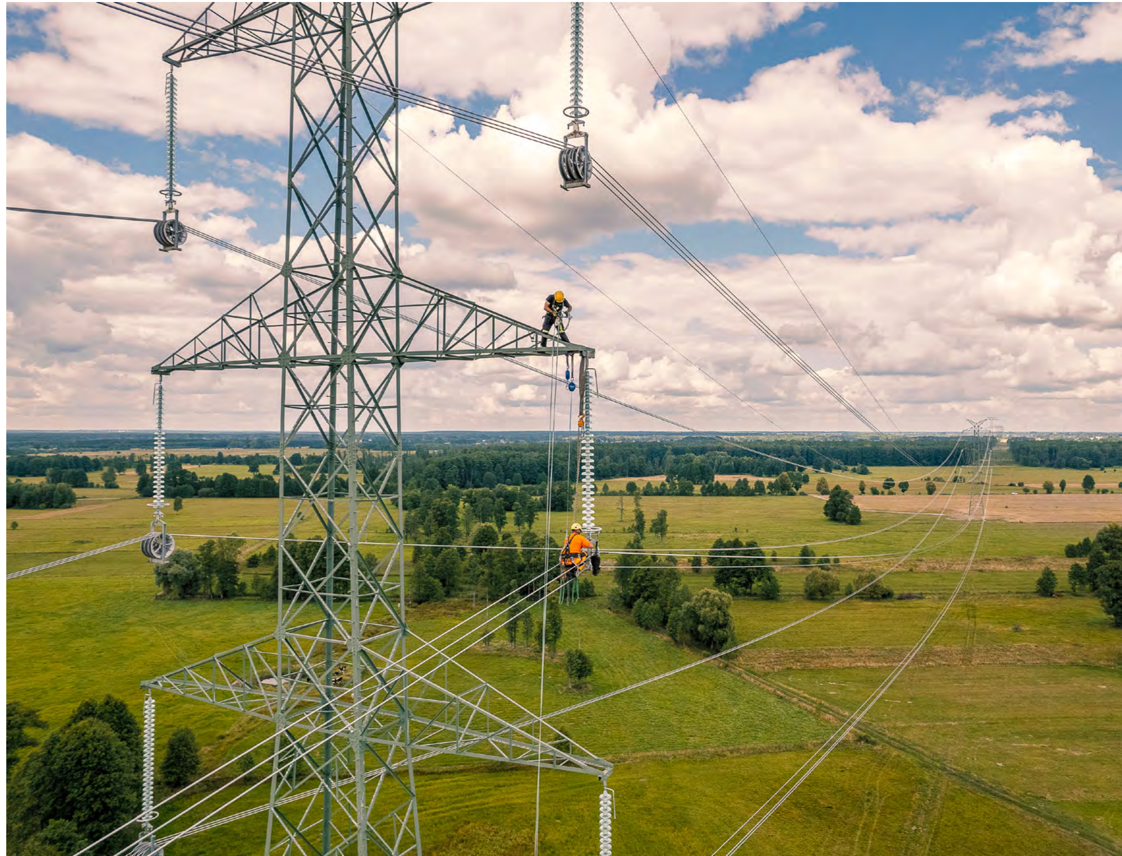
PSE, Budowa linii 400 kV Ostrołęka – Stanisławów
