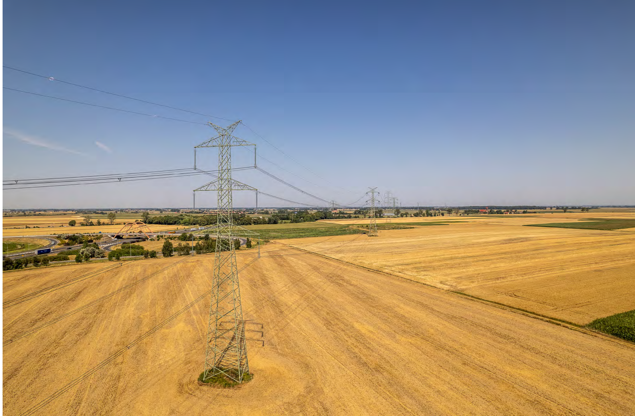
PSE, Dwutorowa linia 400 kV Pasikurówice - Wrocław
