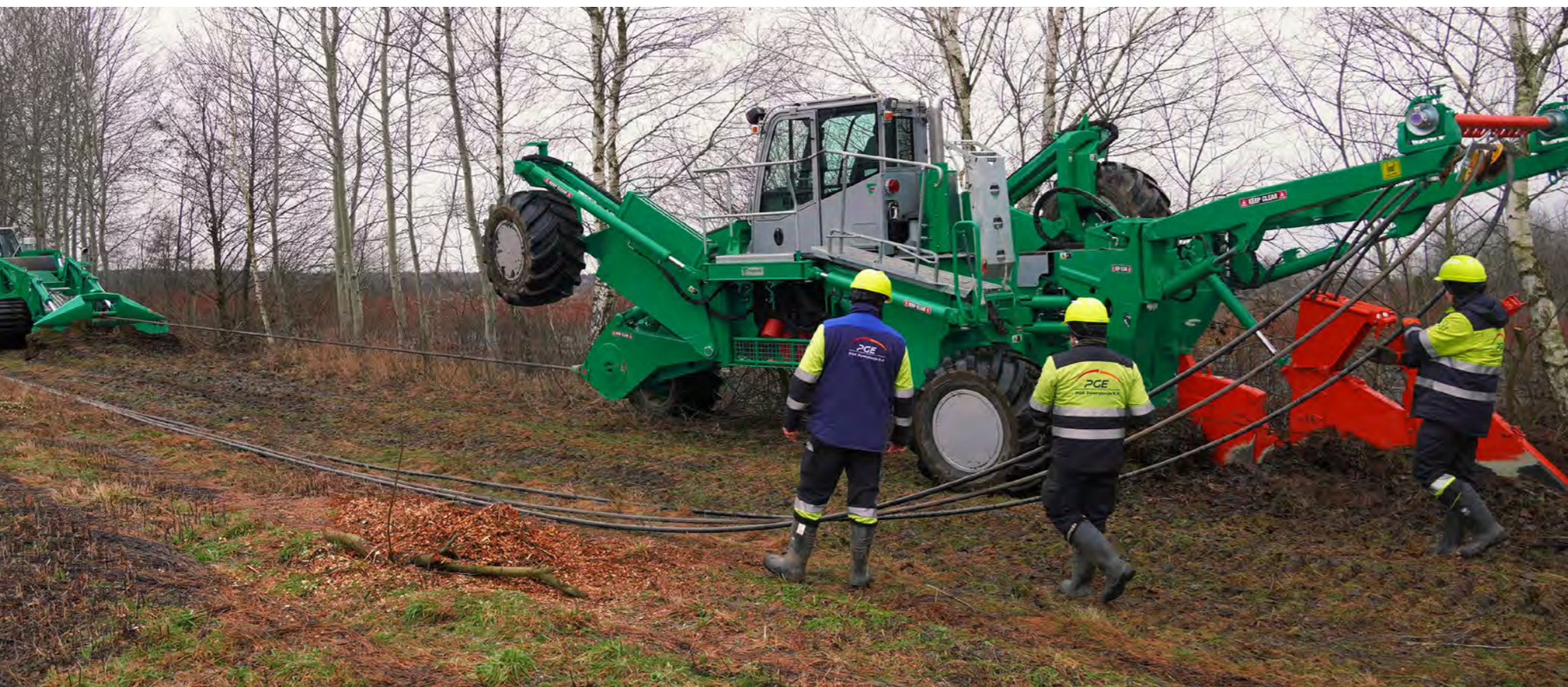
PGE Dystrybucja, Maszyna do kablowania
