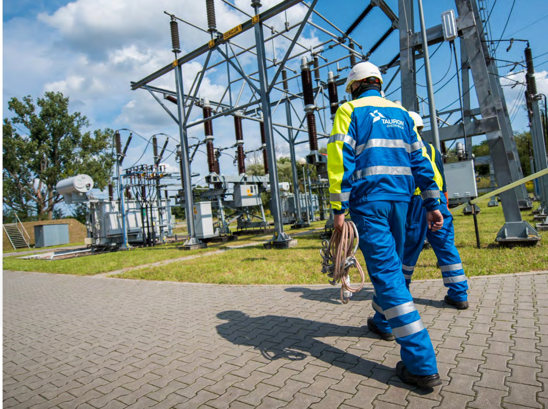
TAURON Dystrybucja, Prace na jednym z GPZ
