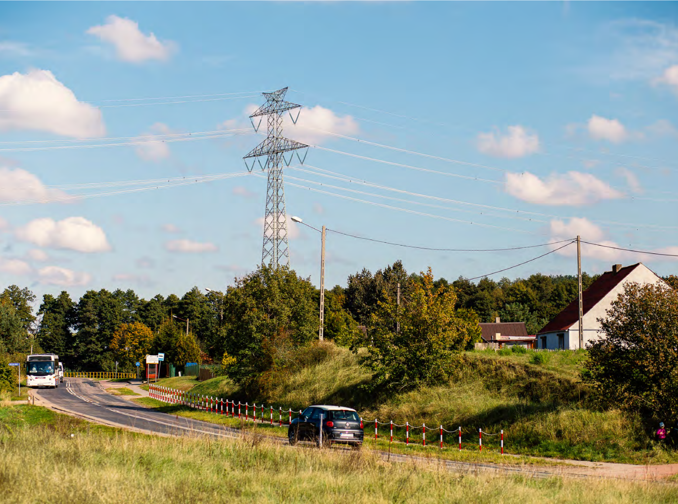
PSE, Stup nadleśny linii 400 kV
