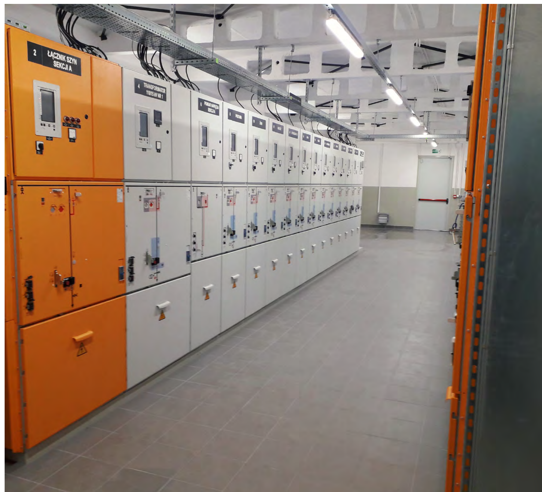
Enea Operator, Modernizacja rozdzielni SN w stacji Mogilno
