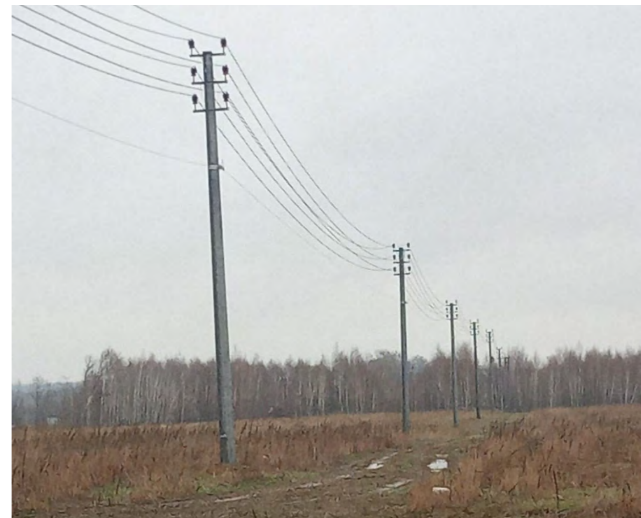
Odbudowa linii średniego napięcia w Obwodzie kijowskim. Po raz pierwszy w sieci ukraińskiej wykorzystano przekazane przez polskich operatorów dystrybucyjnych słupy wirowane.
